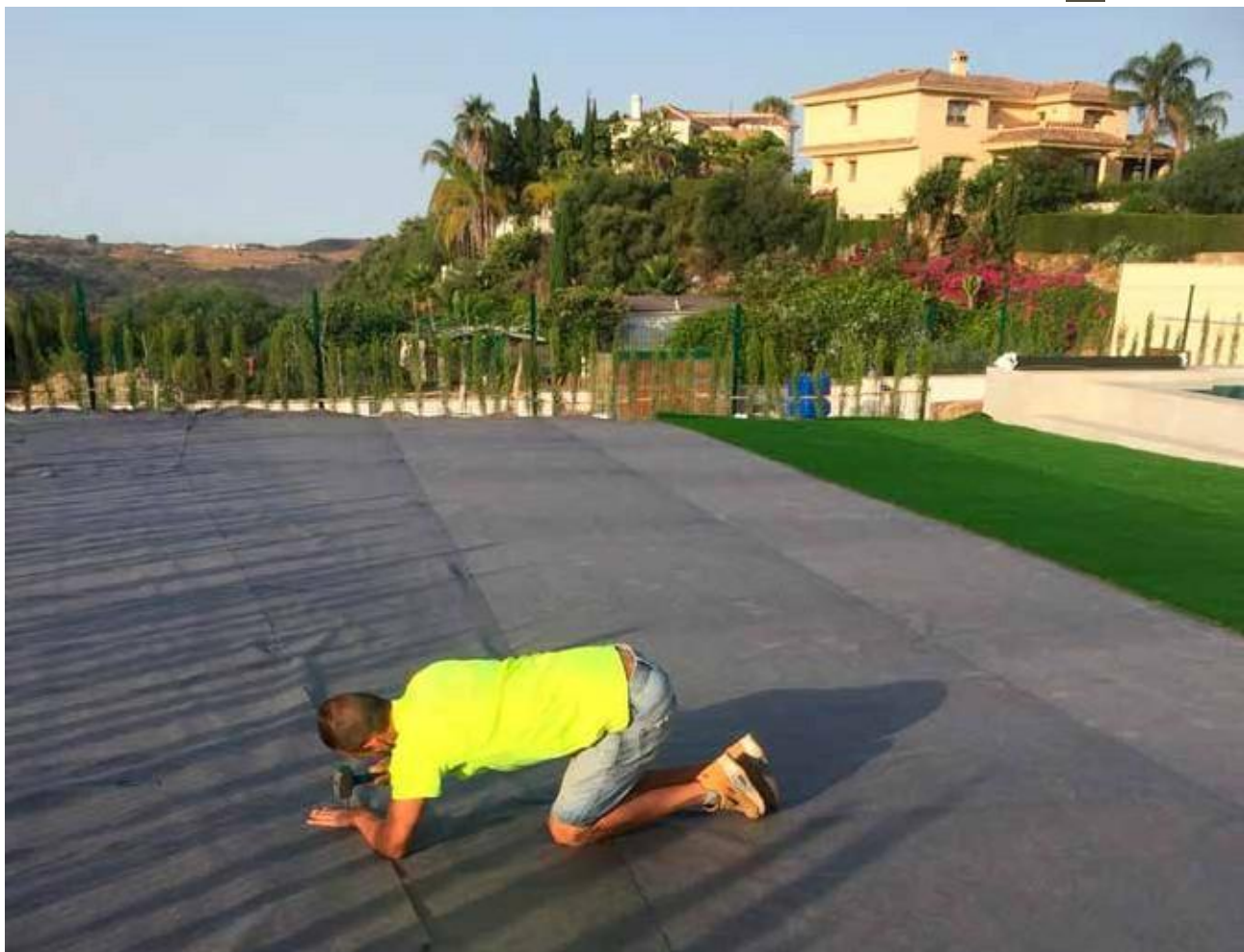
Aplicación de malla antihierbas
